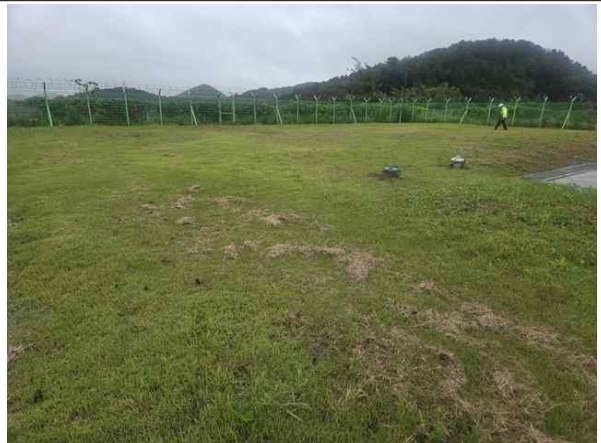
배수지 상부 현황
