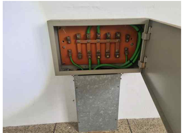
손상내용 접지단자함 상태양호
