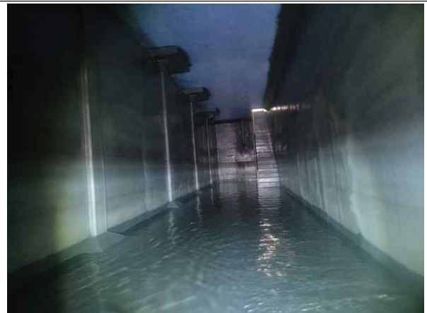
배수지 2지 내부 전경
