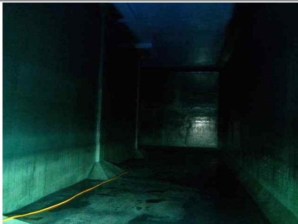
배수지 1지 내부 전경
