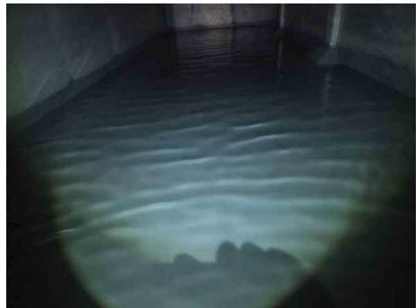
손상내용 2지 바닥슬래브 상태양호 손상원인 -
