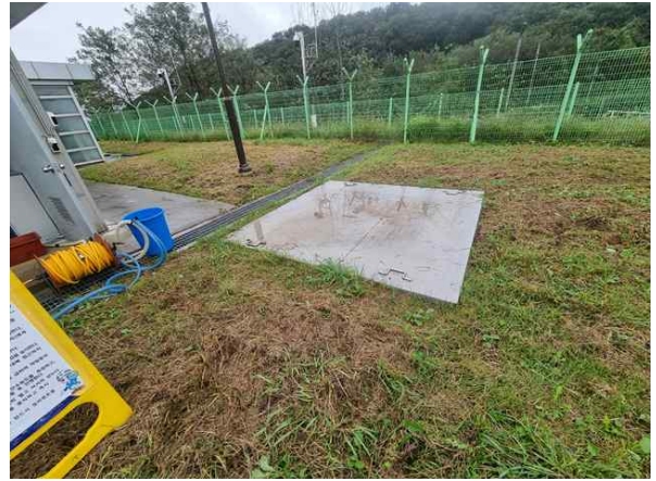
장비 반입구 덮개 현황
