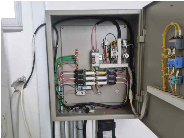
손상내용 분전반 상태양호
