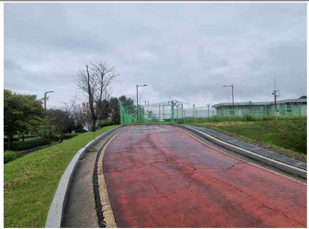
진입로 포장 전경
