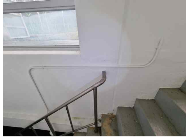
손상내용 검수실 내부 벽체 균열 손상원인 건조수축, 온도변화
