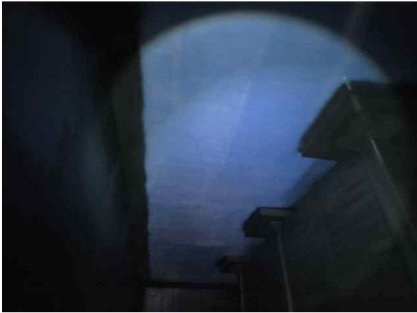
손상내용 2지 상부슬래브 상태양호 손상원인 -
