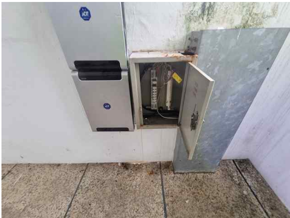
손상내용 현장제어반 상태양호
